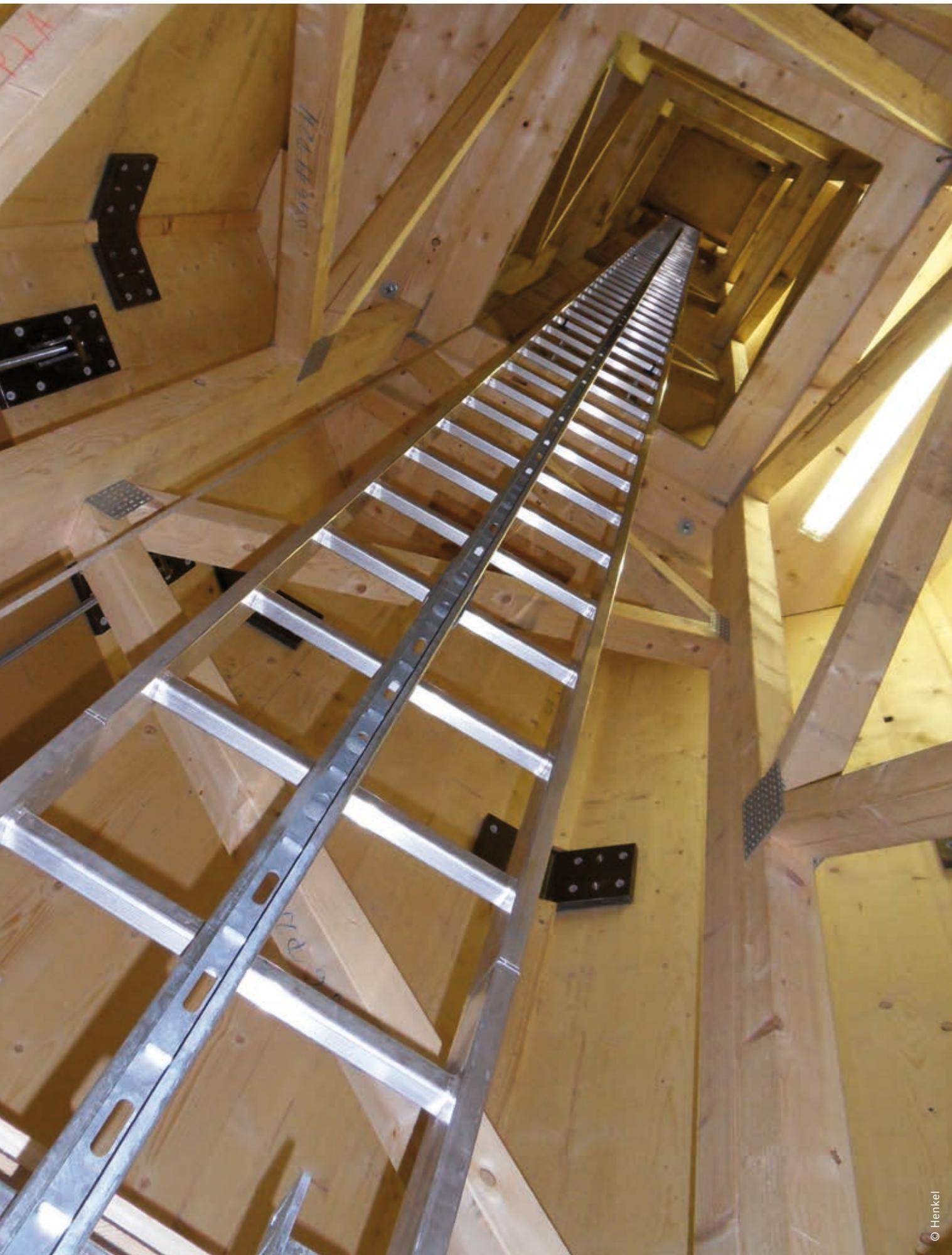
Er ist 100 Meter hoch, achteckig und steht in Hannover – der Turm einer Windkraftanlage aus Fichtenholz. Das Besondere? Er ist komplett geklebt. Die Suche nach Schrauben, Dübeln oder Nägeln: vergebens. Der sogenannte TimberTower könnte eine neue Ära in der Windkraftindustrie einläuten und einen zukunftsweisenden Beitrag zur Energiewende leisten.
