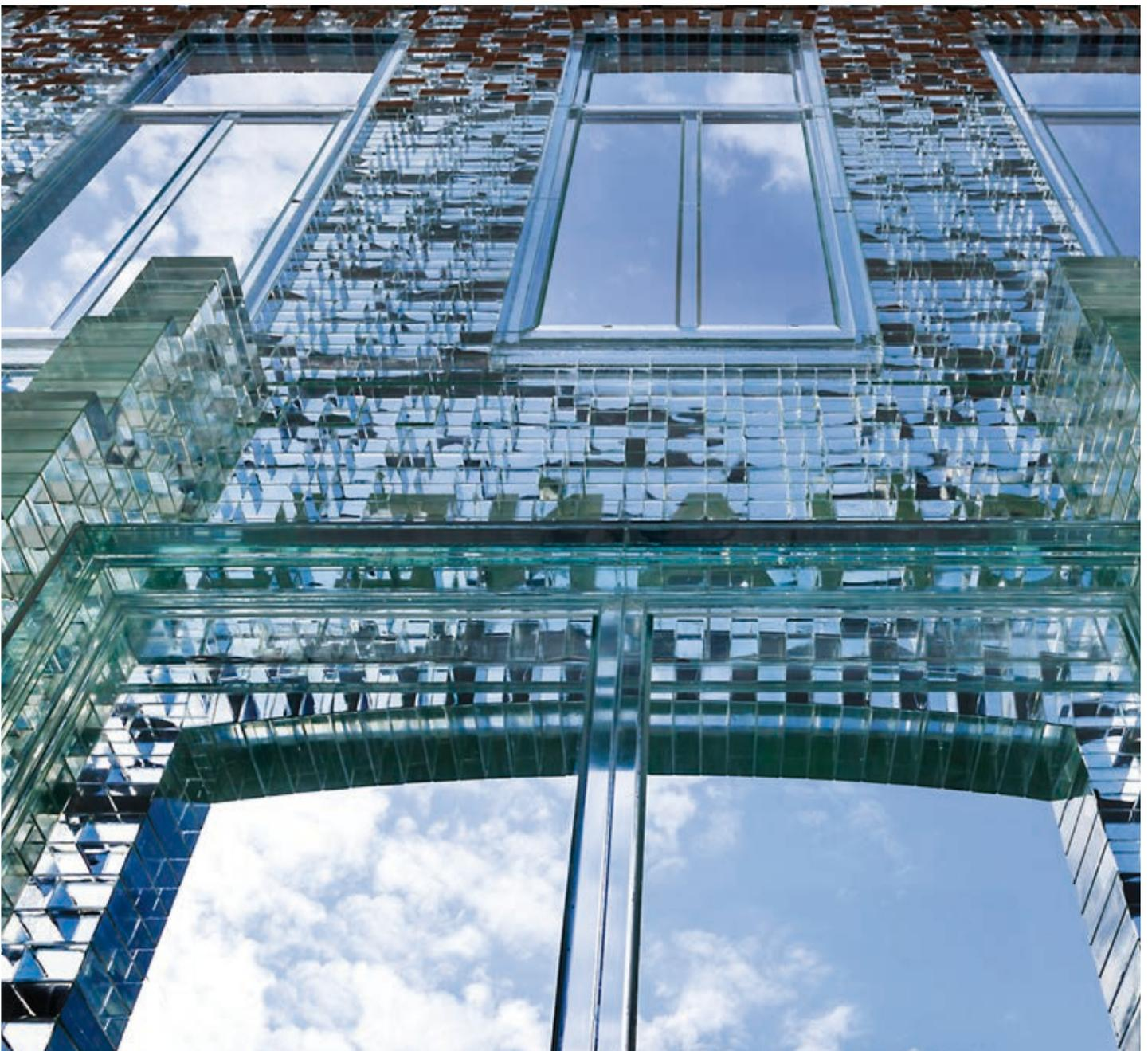
Die Fassade des „Crystal Houses“ besteht aus mehr als 7.000 handgefertigten durchsichtigen Glasbausteinen.
