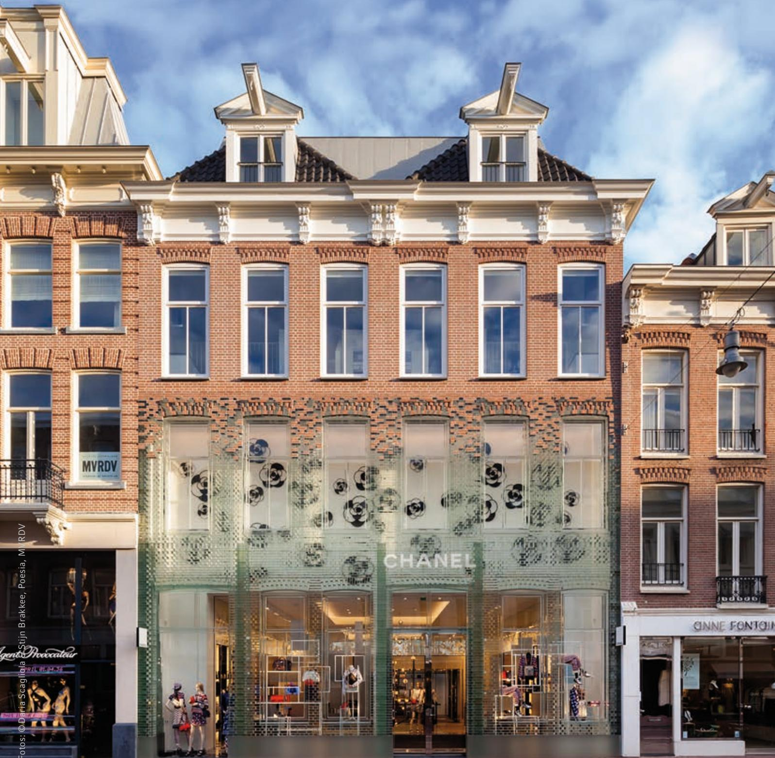
„Crystal Houses“ in Amsterdam mit dem Flagshipstore von Chanel ist ein Bauwerk der Superlative. Ein gläserner Palast, Stein um Stein geklebt.
