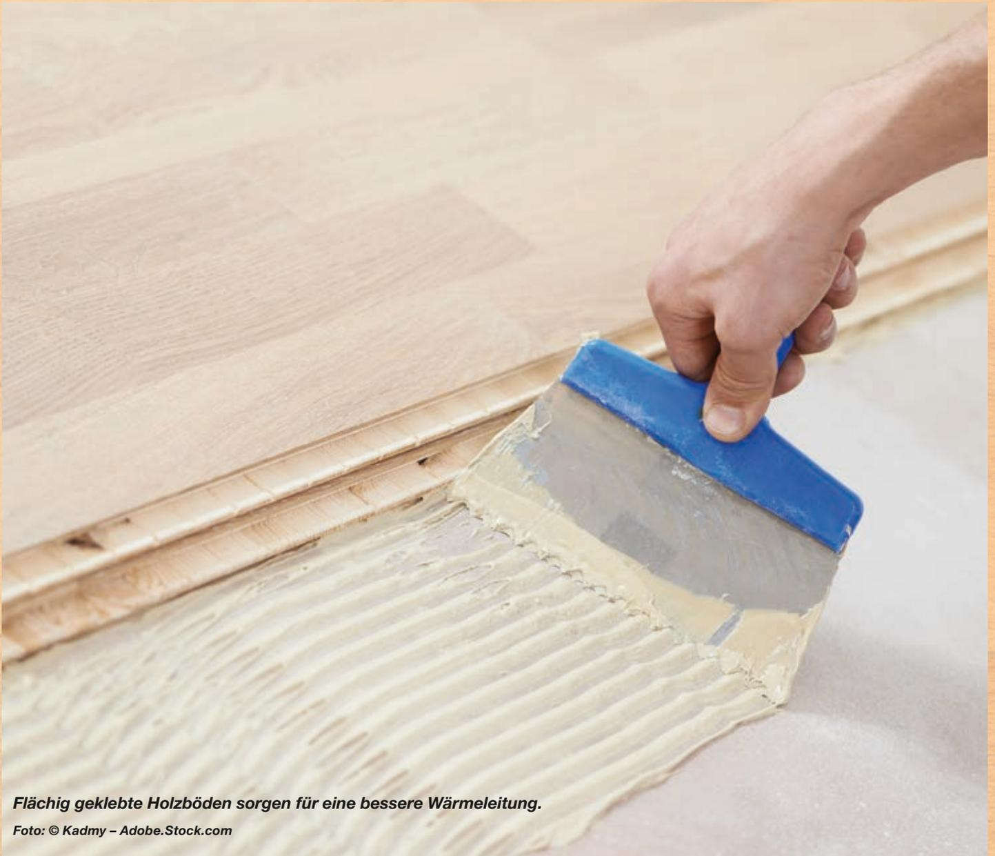
*Flächig geklebte Holzböden sorgen für eine bessere Wärmeleitung.*
