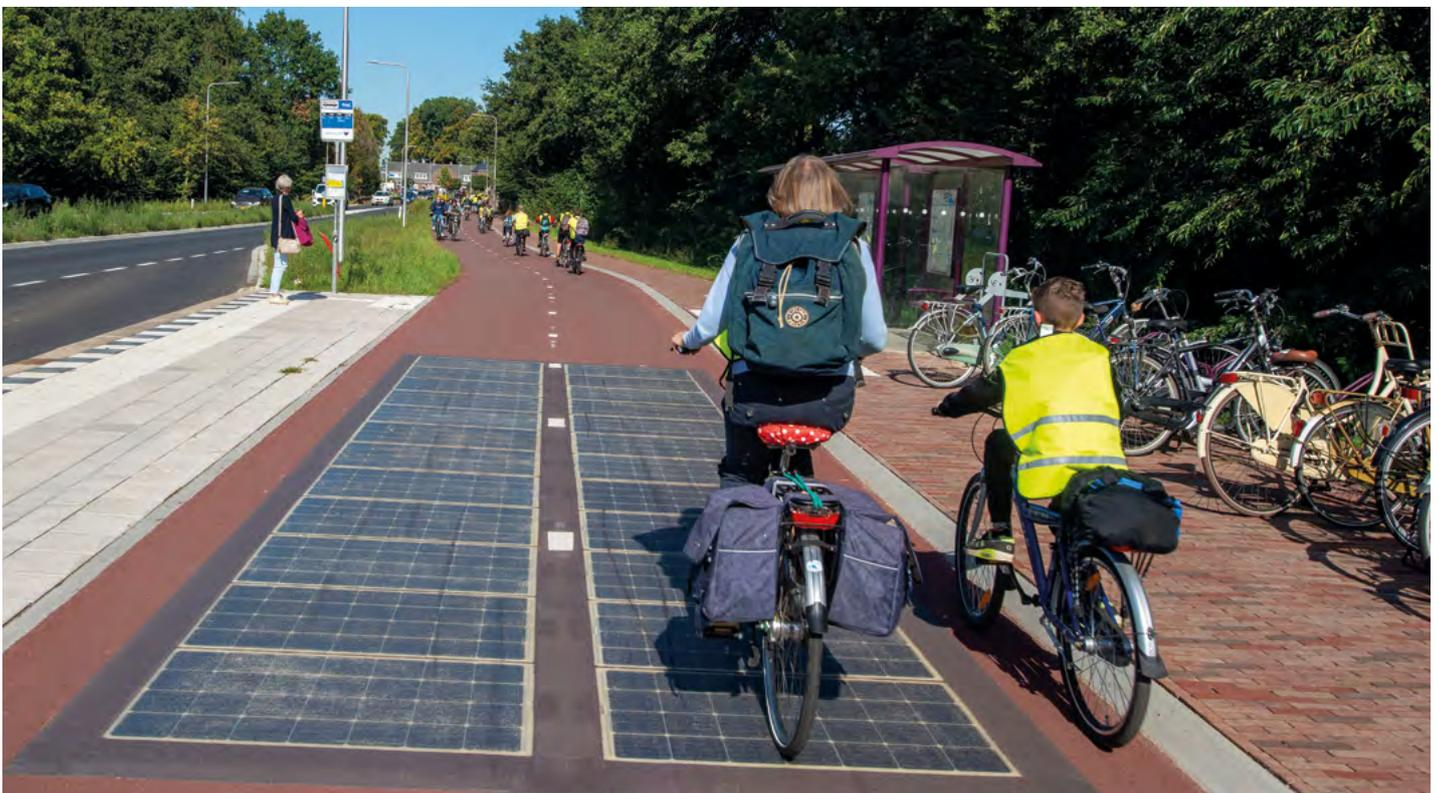
**Die dünnen Solar-Platten werden mit einem Zweikomponentenklebstoff auf eine vorhandene, ebene und unbeschädigte Verkehrsfläche geklebt - ganz egal ob Straße, Fahrradweg oder Parkplatz.**
