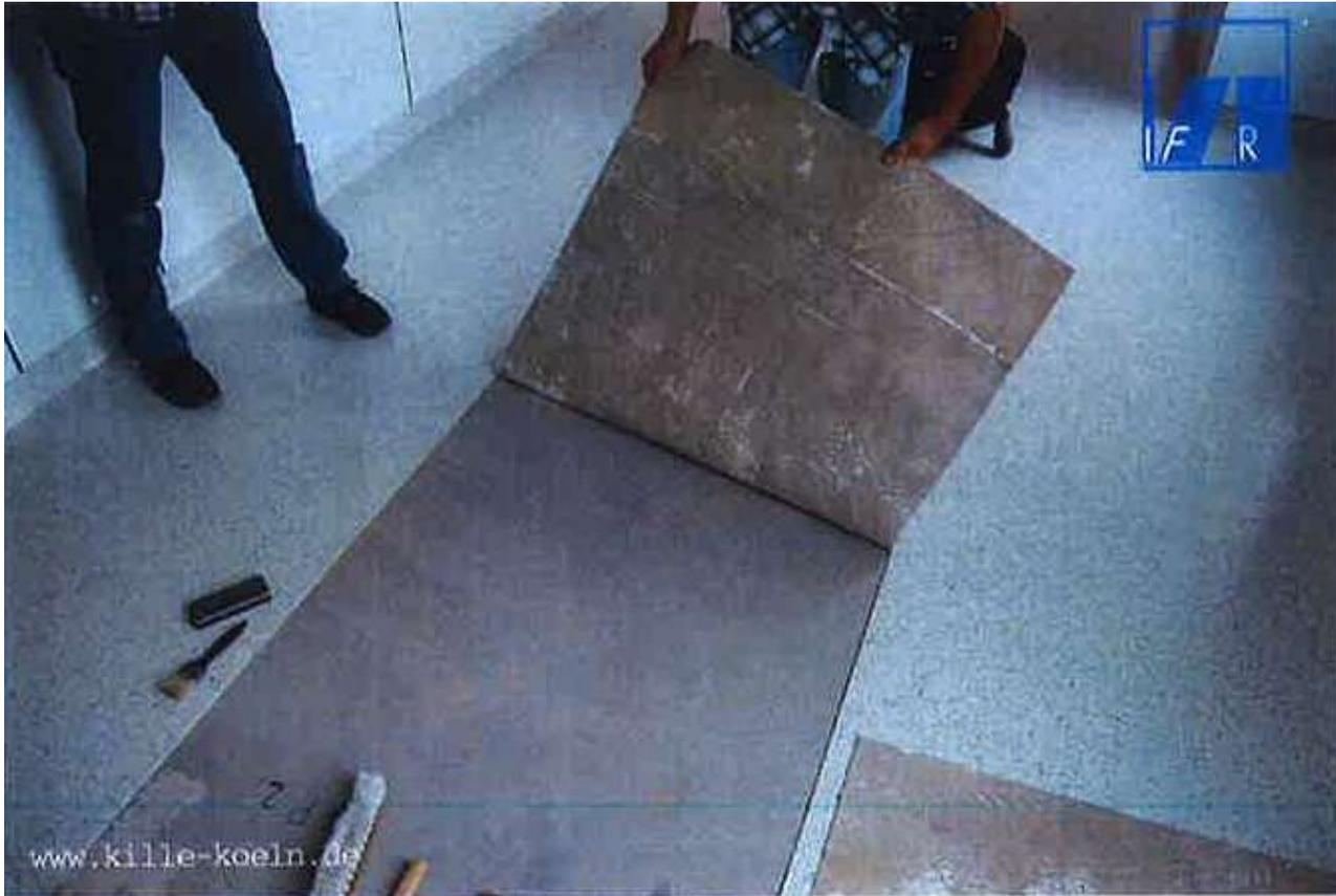
Chemische Wechselwirkung zwischen oberster Spachtelmassenschicht und Dispersionsklebstoff => Ablösung einer dünnen Haut Spachtelmasse
